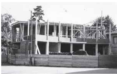
Il cinema in costruzione
